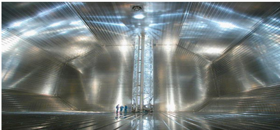
Рис. 1. Фото Мембранного танку зсередини
